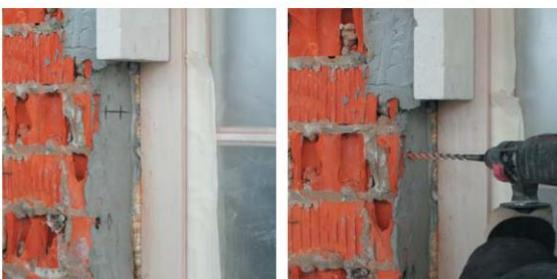
Устанавливается анкер. При необходимости анкер может дополнительно фиксироваться расширяющимся kleem, например марки «Клейберит».
