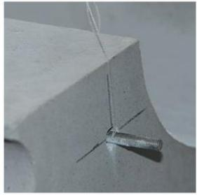
Изделие вешается на анкеры, и фиксируется kleевой смесью. При точном позиционировании тяжелых элементов используются клинья и технологические анкеры, играющие роль упоров.
