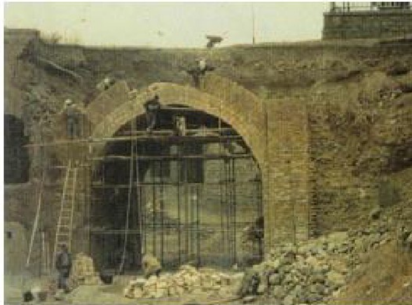
اجرای تاق رومی بر روی قالب دائمی از تاق پر، پل شاه عباسی کرج،
