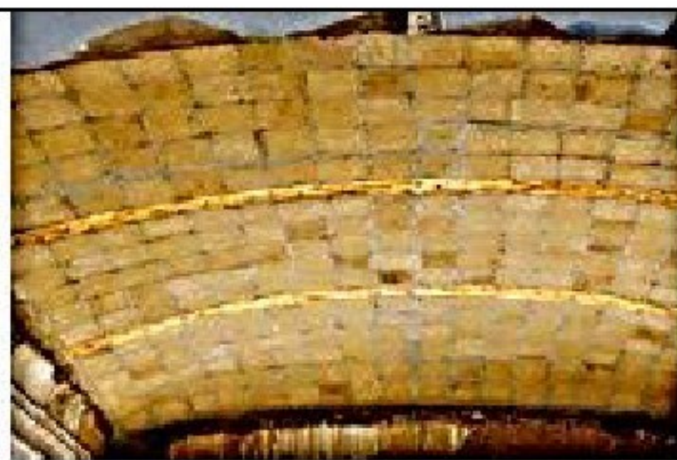
کمربندهای پر در طاق های لاپوش آشکارا دیده می شوند، خانه هایی در کاشان و تهران، مأخذ: آرشیو مرکز استاد دانشکده معماری دانشگاه شهید بهشتی و مقاله برای هتدمه طاق و گنبد
